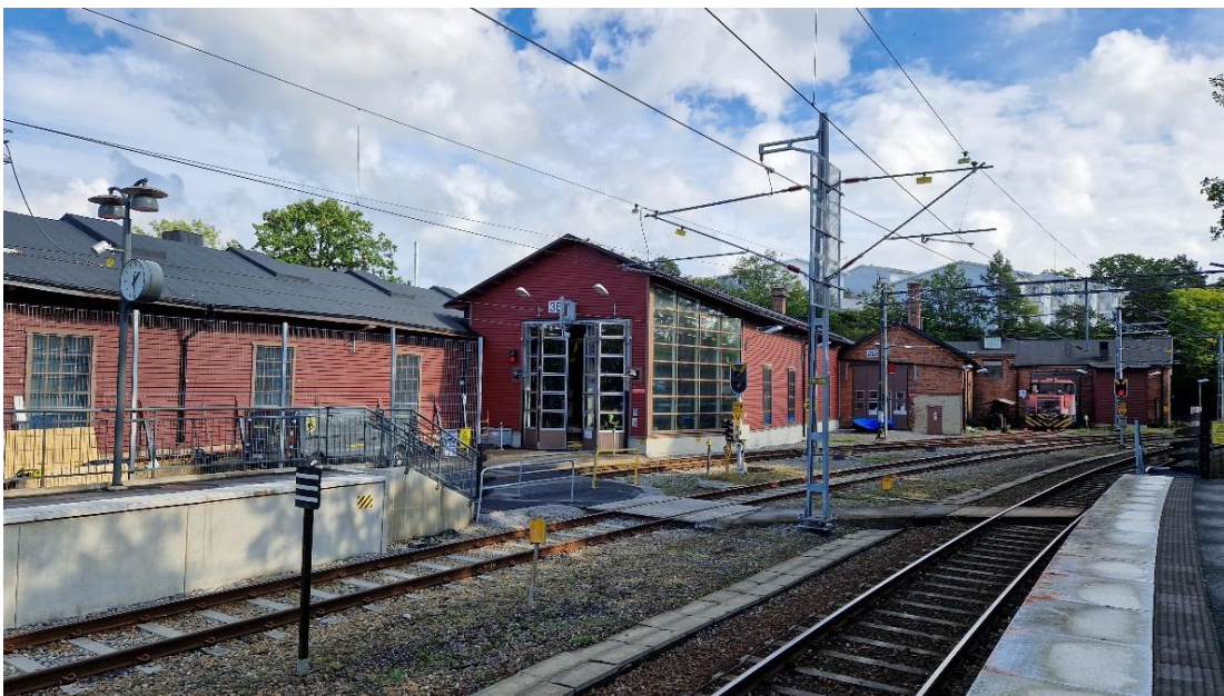
Figur 21. En av de äldre verkstadsbyggnaderna i tegel har förlängts med en ny hall. Nybyggnaden har anpassats till miljön vad gäller takvinkel, fasadmateriel och fönstersättning.
