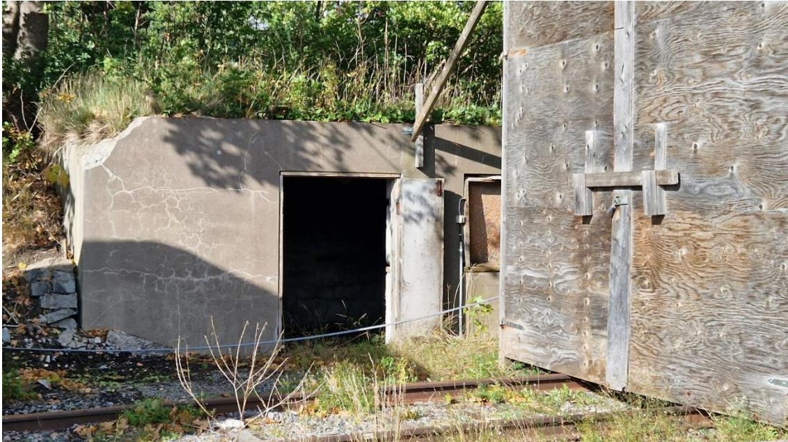
Figur 16. Mot Torsvägen finns en betongkällare som troligen är den oljekällare som nämns i ett arrendavtal från 1969. Källaren kommer rivras som en följd av förslaget.
